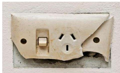
Plastična navlaka glavne utičnice je djelimično slomljena zbog nemarnog postupanja. Radnik to mora prijaviti nadređenom kako bi pozvao električara koji će zamijeniti i ponovo povezati utičnicu.
