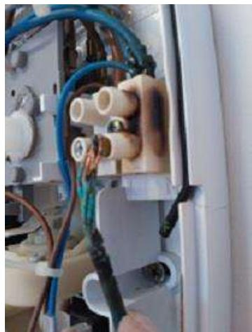
Izolacija električnih žica je pokvarena, a poklopac kontrolnog panela nedostaje. Radnik to mora prijaviti nadređenom kako bi pozvao električara koji će ponovo povezati i izolirati električne žice i zamijeniti plastični poklopac.
